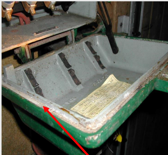
Switchgear Door Seal
